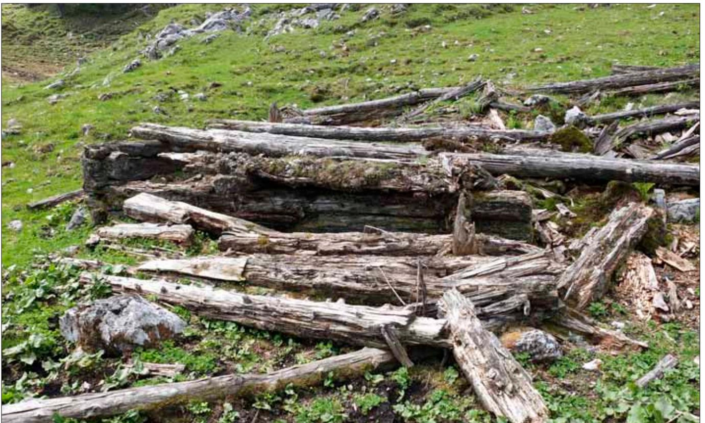
Almhütte (Objekt 201), Plankenalm 2012. Nordostseite mit den durch den Schneeedruck nach außen gefallenen Holzteilen des Blockbaues.
