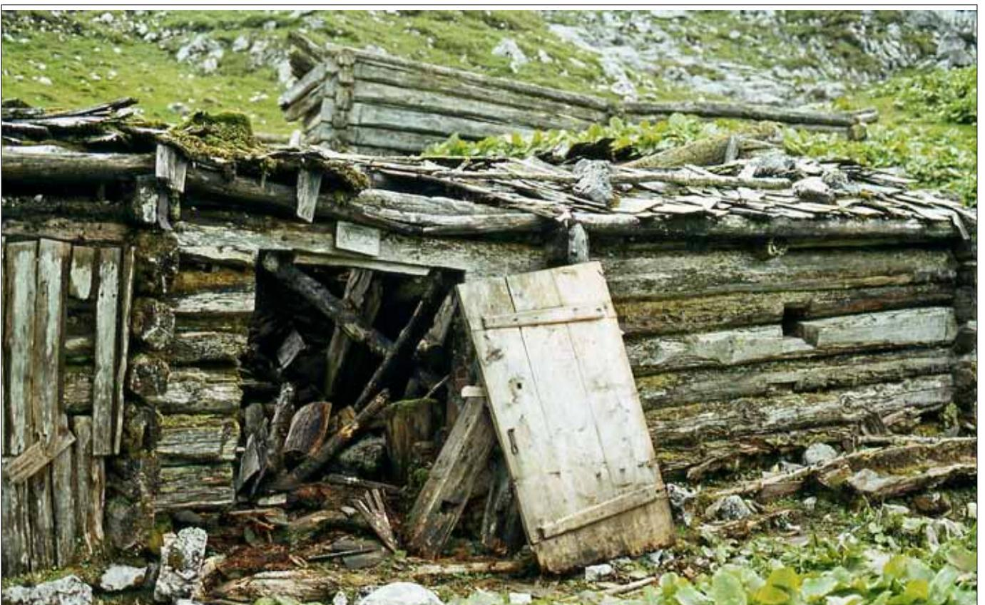
Almhütte (Objekt 201), Plankenalm 1980, Eingangsbereich mit Herdstelle. Im Inneren der Hütte sieht man herabgefallenen Holzteile des Daches. Das mit Feldsteinen gelegte Fundament mit seinen massiven Eck- und Stützsteinen der Außen- und Zwischenwände war 30 cm hoch. Die Tür war herausgefallen und wurde aufgestellt.
