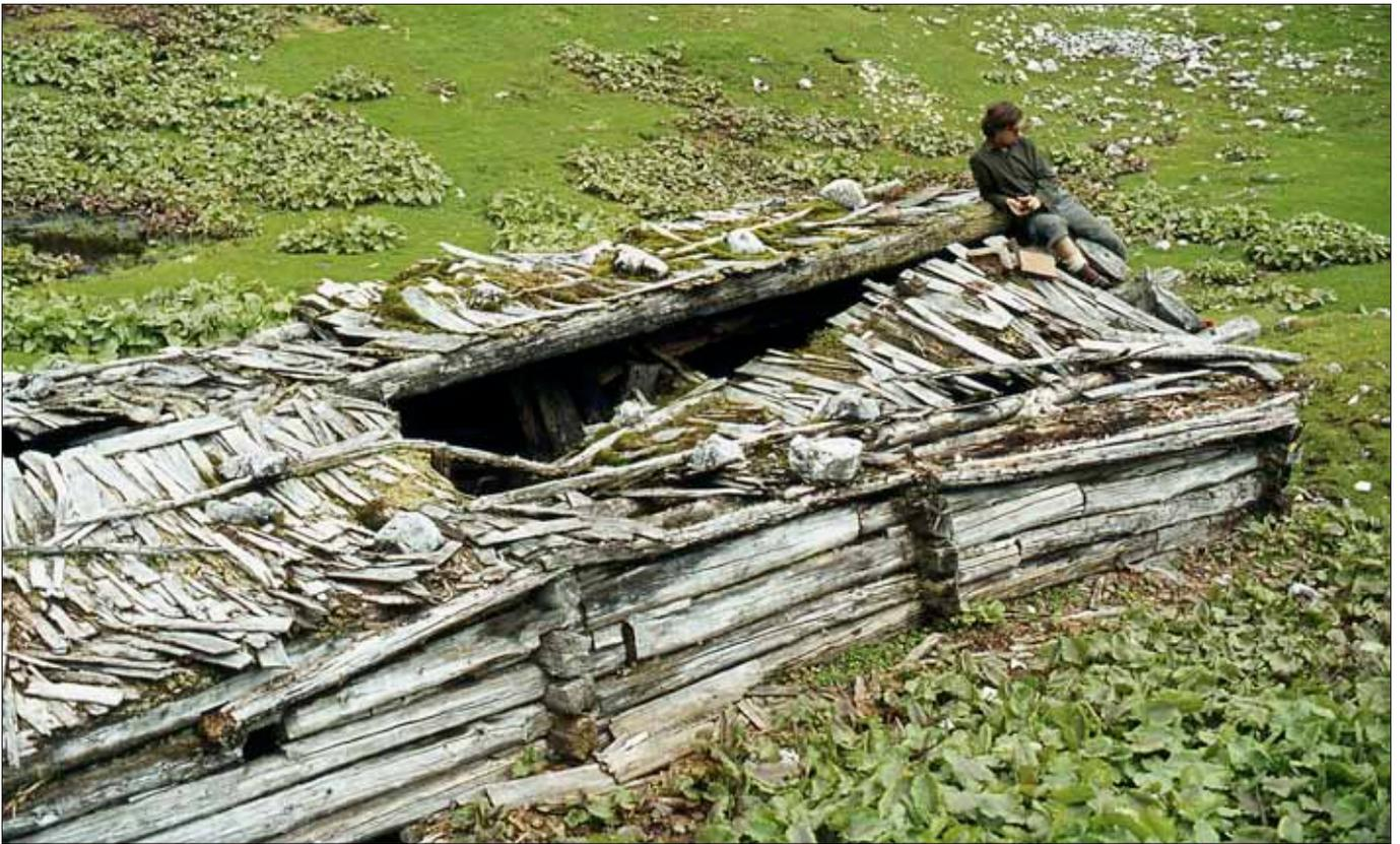
Almhütte (Objekt 201), Plankenalm 1978. In Auflösung befindliches *Ansdach* mit Legschindeldeckung. Die Südwand des Blockbaus weist Ausbesserungsarbeiten auf. Die Hütte ist nicht mehr benützbar.
