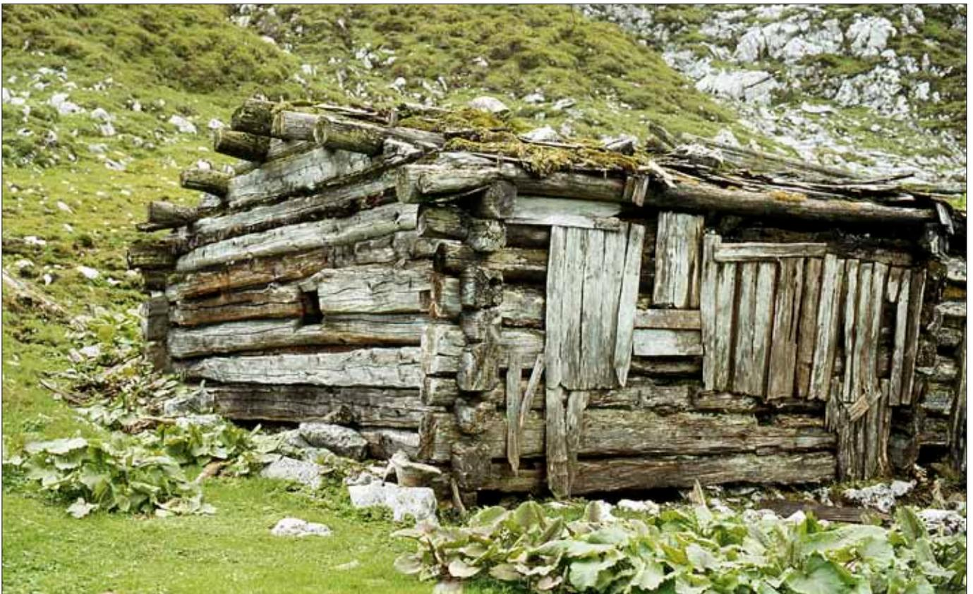
Almhütte (Objekt 201), Plankenalm 1980. An der Nordostseite erreicht der Blockbau mit dem Dach eine Höhe von 2,4 m. Die Nordseite war ursprünglich zum Schutz vor der Witterung mit Brettern verschlagen worden, die teilweise noch vorhanden sind.
