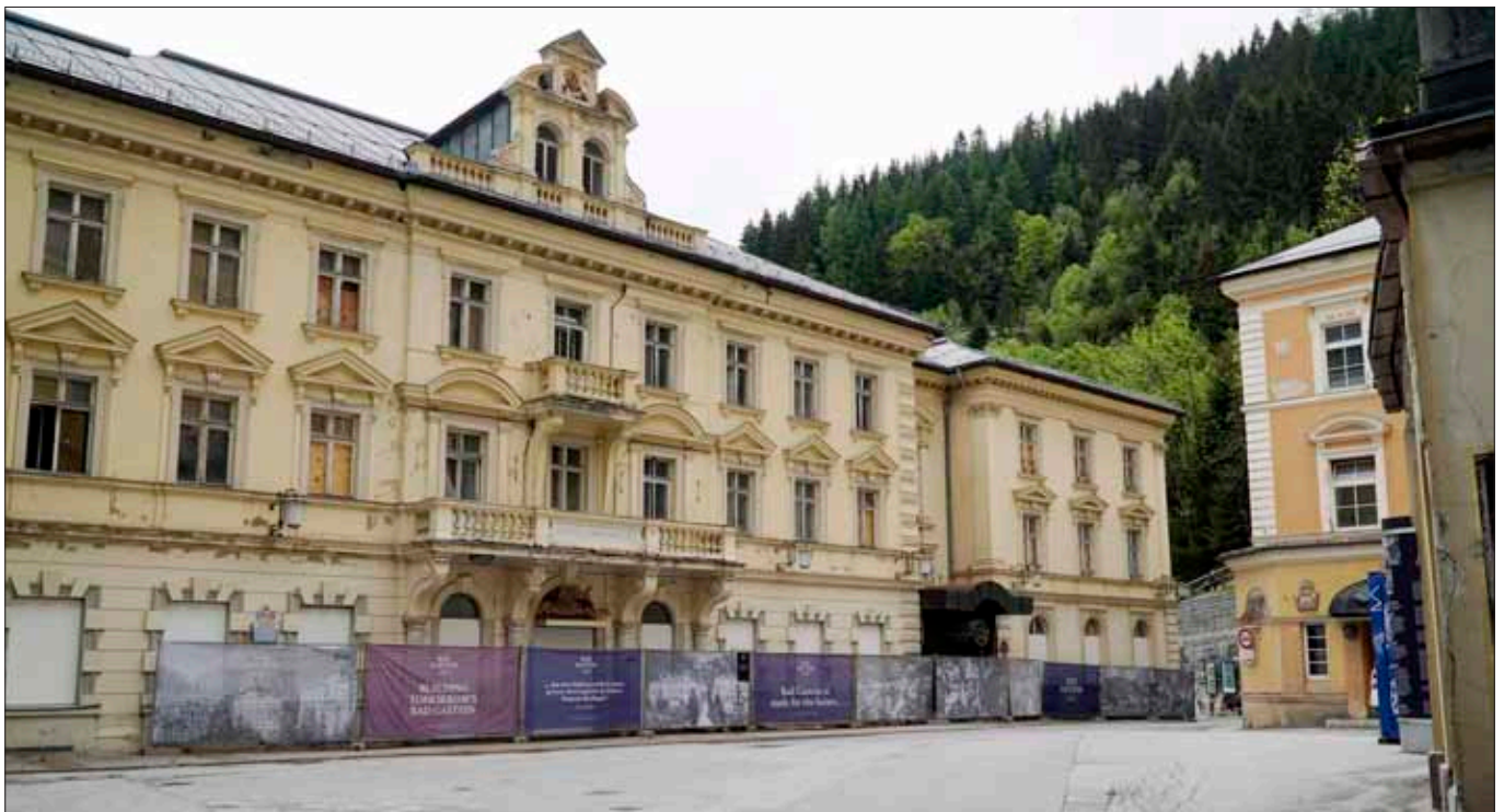
Das denkmalgeschützte, ehemalige Luxushotel Straubinger wurde von 1840 bis 1842 von Architekt Josef Wessicken errichtet. Es stand bis 1980 im Besitz der Gasteiner Hoteliersfamilie Straubinger. Nach der Einstellung des Hotelbetriebs 1999 wurde es zum Spekulationsobjekt und verfiel. Im November 2017 erwarb das Land Salzburg das Gebäude und plant nun eine Revitalisierung. Foto: F. Mandl 2020.
