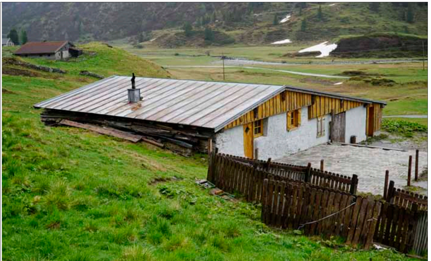
Abbildung 13 Die Moisesalm Aus Gründen des Lawinenschutzes wurde die niedere Hütte in den Hang gebaut. Sie besitzt keinen Zubau. Alle benötigten Räumlichkeiten befinden sich in der Hütte. Foto: ANISA/F. Mandl, 2020.
