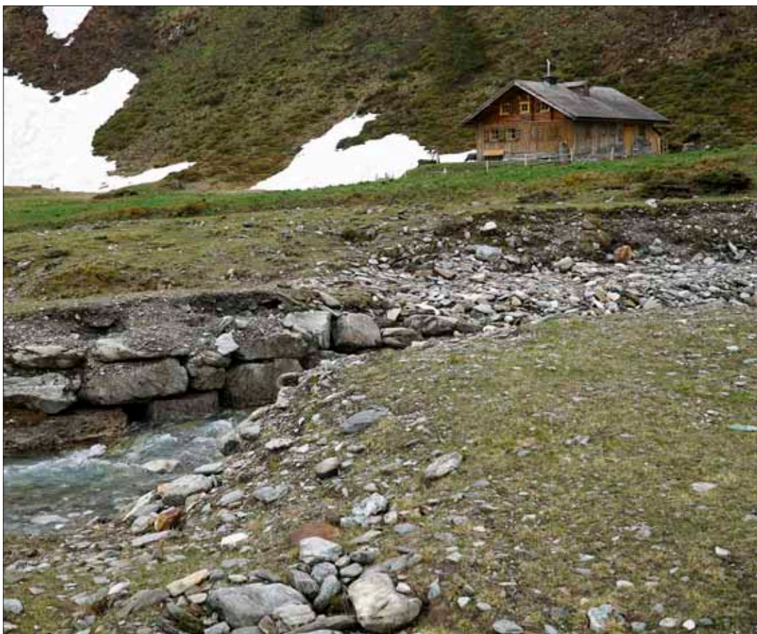
Abbildung 1 Schmoranzelalm. Blick über die weggerissene Brücke des Höllkarbaches zur Hütte der Schmoranzelalm. Foto: F. Mandl/ ANISA 2020.
