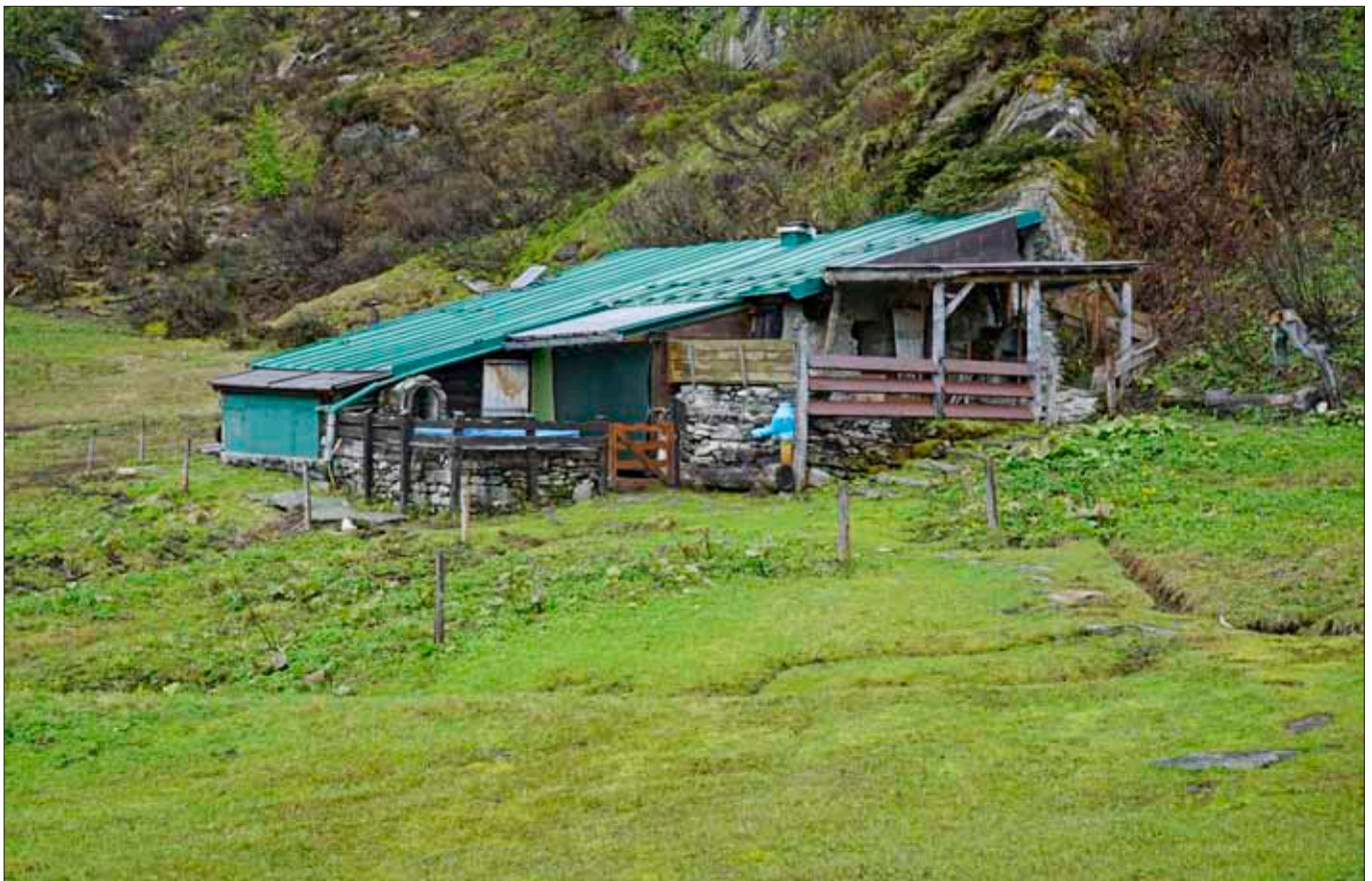
Abbildung 2 Krugalm. Eine wegen des Lawinenschutzes an den Berghang gebaute, etwas verschachtelte, mit Blech gedeckte Hütte. Almenkarte Nr. 20. Foto: ANISA/F. Mandl, 2018
