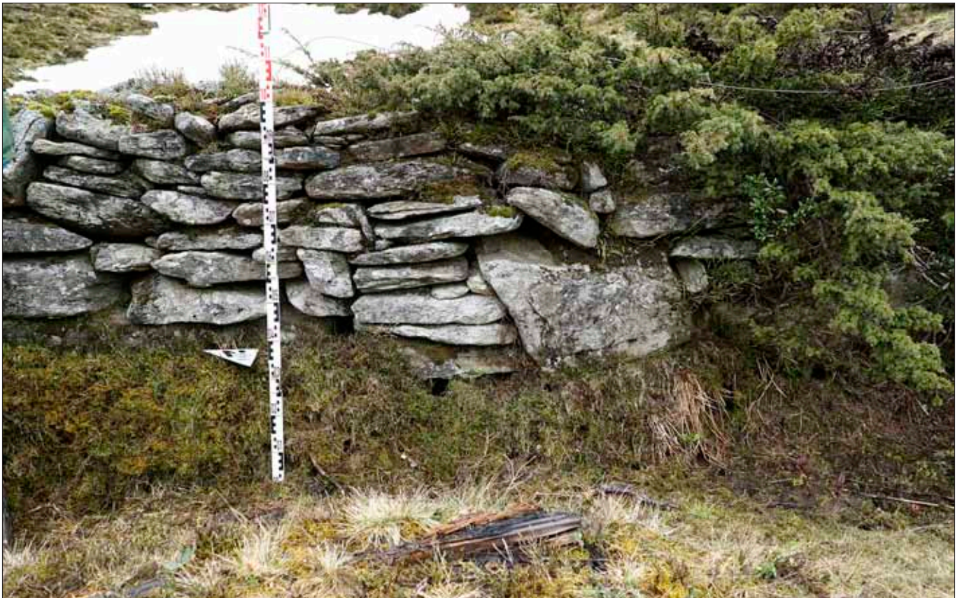
Abbildung 13. Hinternaßfeldalm. Nördlicher Bereich. Legetechnik der aufgesammelten Feldsteine. Ein Werk für Jahrhunderte. Foto: F. Mandl/ANISA 2020.
