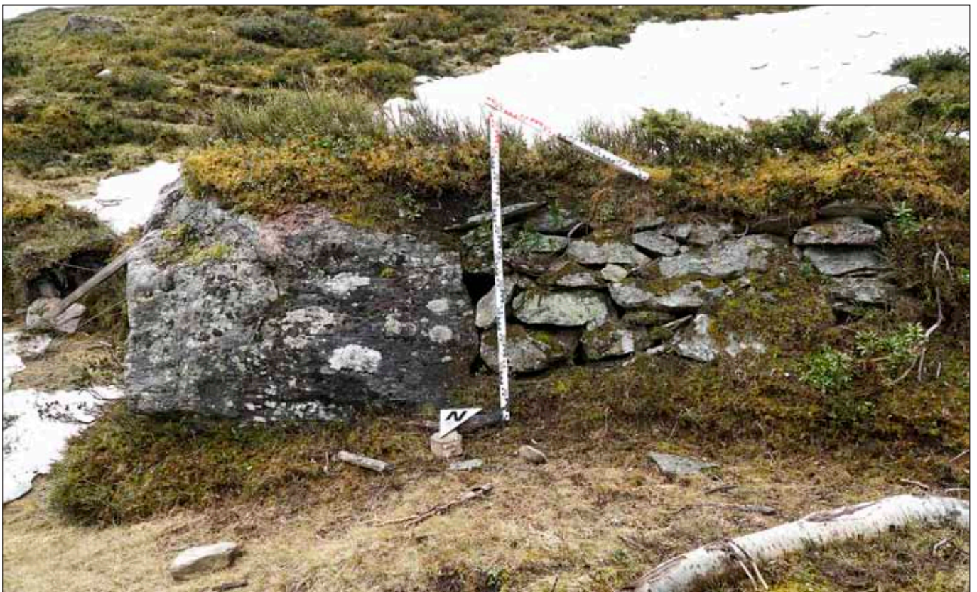
Abbildung 14. Hinternaßfeldalm. Nördlicher Bereich. Legetechnik der aufgesammelten Feldsteine. Gerne werden massive Steine als Stütze in die Mauer einbezogen. Foto: F. Mandl/ANISA 2020.
