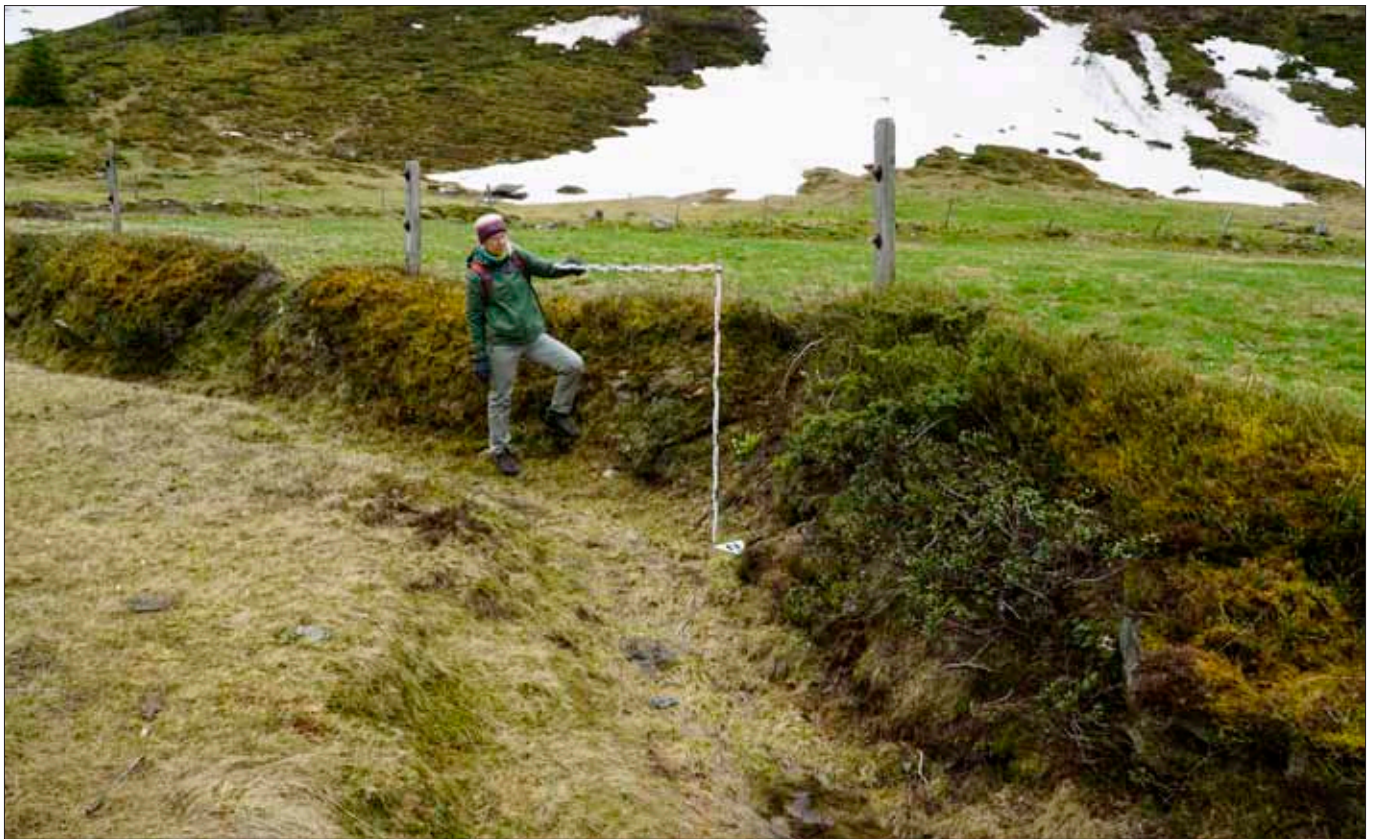
Abbildung 17. Hinternaßfeldalm. Südlicher Bereich. Legsteinzaun des Heuangers mit Zaunpflocken für einen Elektrozaun und Abflussrinne. Foto: F. Mandl/ANISA 2020.
