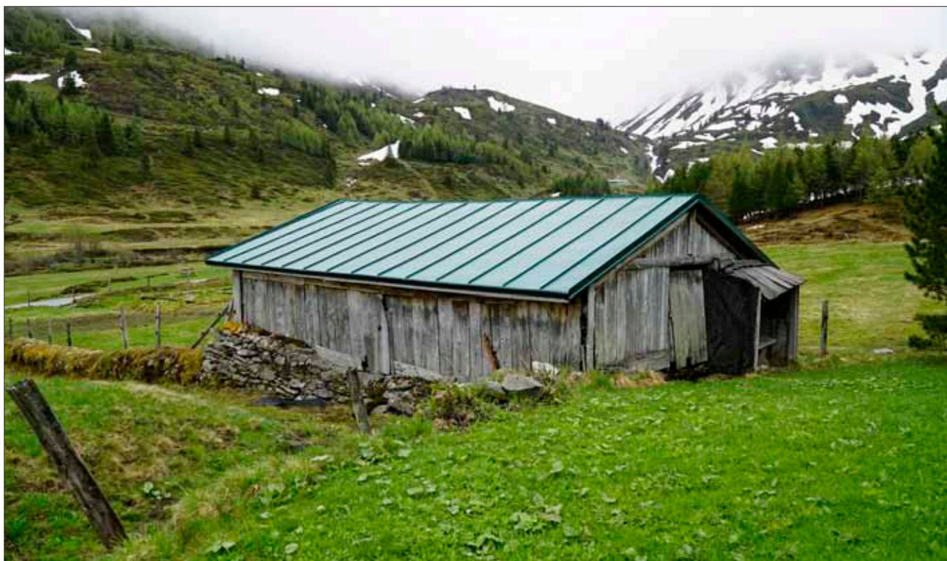
Abbildung 6 Hinternaßfeldalm. Nordseite der Hütte mit Legsteinwand ohne Mörtelsicherung. Blechdeckung. Foto: F. Mandl/ANISA 2020.
