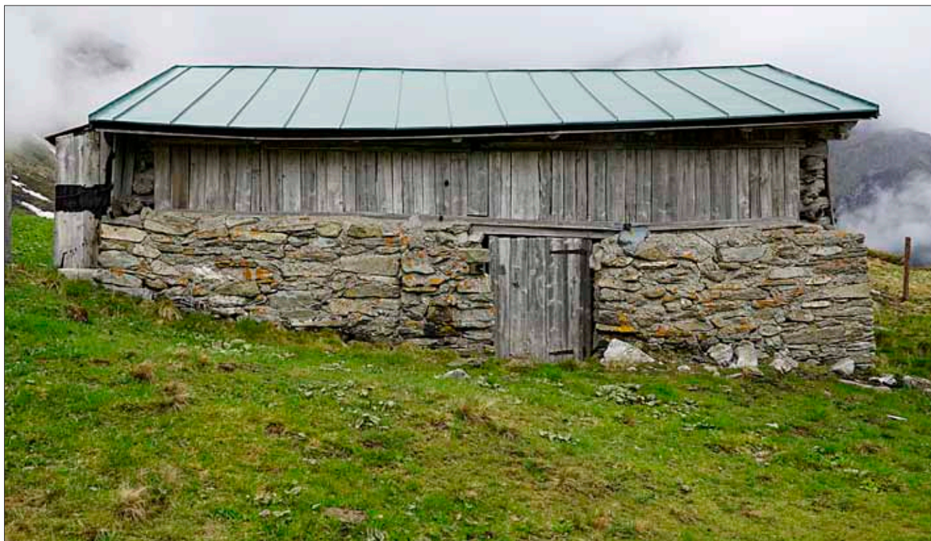
Abbildung 5 Hinternaßfeldalm. Ebenerdiger Steinbau mit Eingang und Holzaufbau mit bretterverschlagenen Blockwänden. Nachträglich mit Mörtel gefestigt. Mehrere Baustufen. Blick gegen Norden. Als Keller geeignet. Foto: F. Mandl/ANISA 2020.
