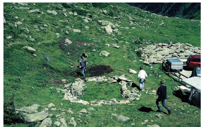
Abb. 71: Fundament nach Wiederherstellung
