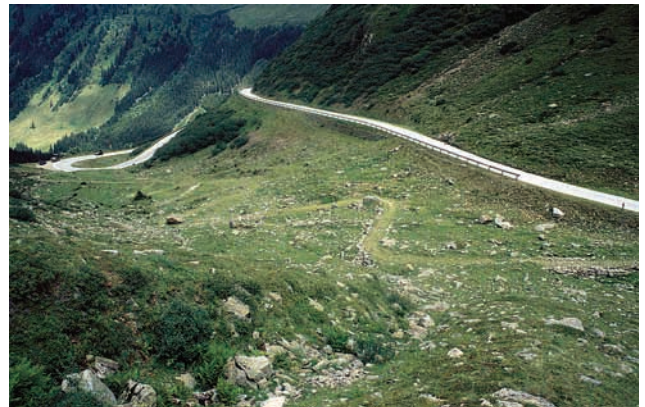
Abb. 72: Altwege nördlich der Passhöhe
