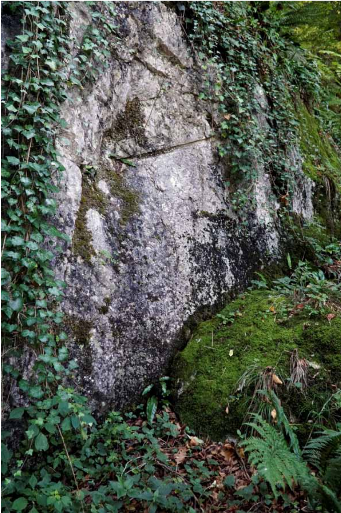
Absprengstelle westlich der Bildstelle 9 mit darunter liegendem Gesteinsblock
