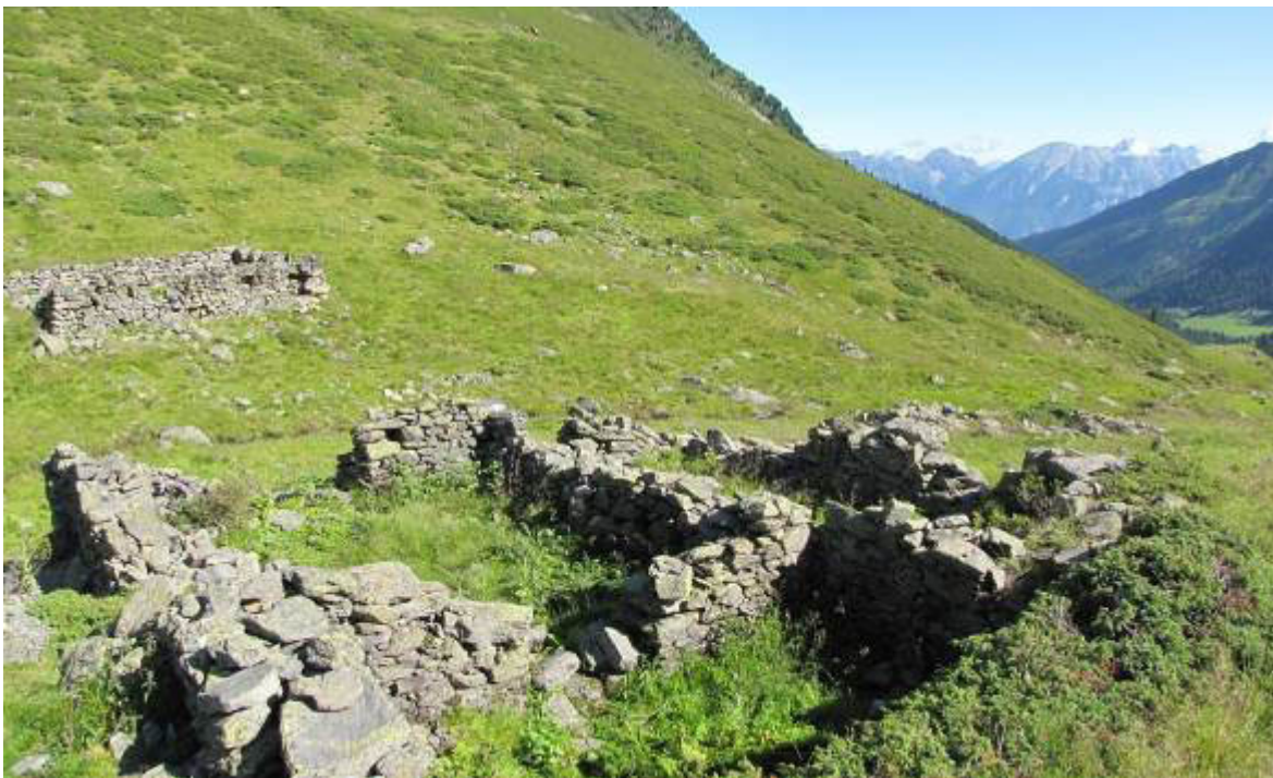
Abb. 26: Ungerberger Hüttn, verfallene Almhütte, links hinten der Stall
