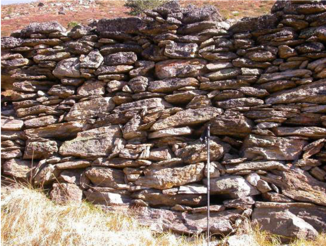
Abb. 37: Schönlisensalm. Sorgfältig geschichtete hangseitige Mauer der einstigen Almhütte
