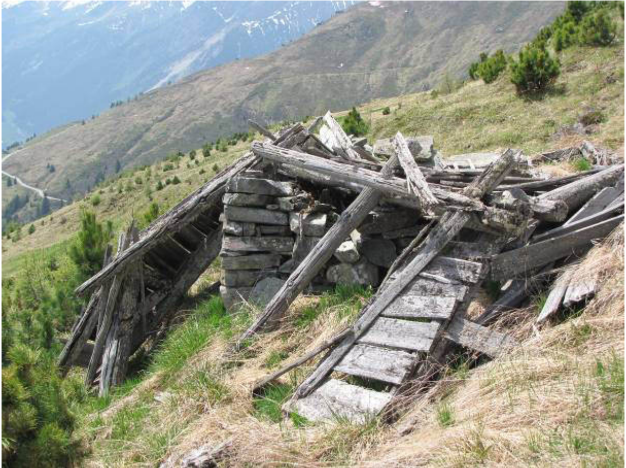
Abb. 43: Verfallene Kochhütte am Sellrainer Sonnberg, Blick nach Südwesten
