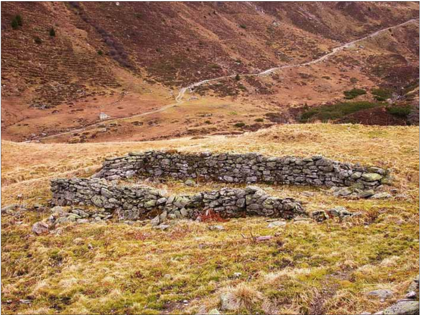
Abb. 7: Arztaler Alm 1.970 m, VB Innsbruck-Land, KG Pfons Verfallener Stall. Innenmaße 10 x 4 m, Mauerstärke 60-70 cm, Mauerhöhe max. 1,30 m
