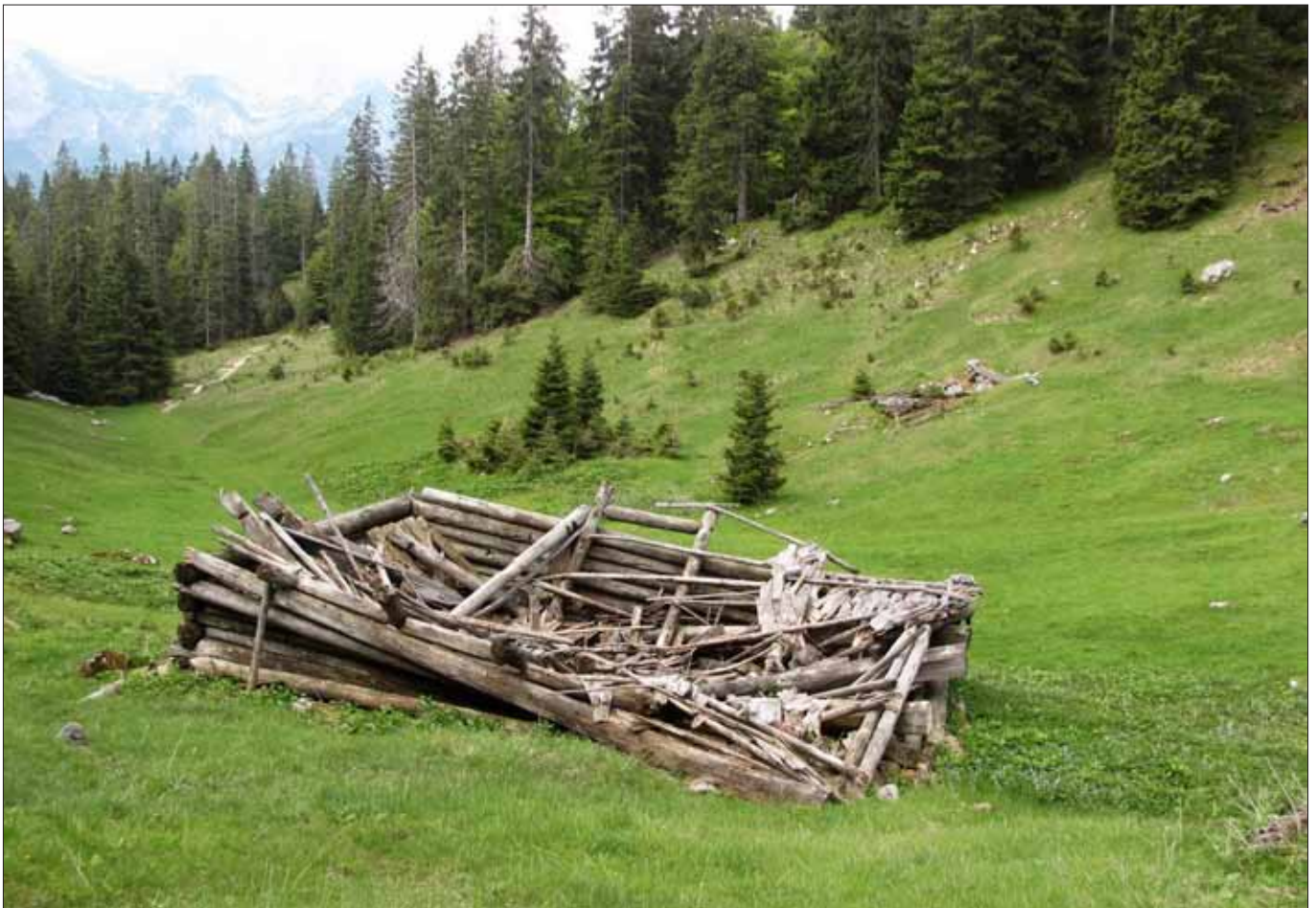
Abb. 3: Kotalm, 1.450 m, VB Schwaz, KG Steinberg Verfallene zweiräumige Almhütte in Holzbauweise, Innenmaße 7,0 x 4,5 m Das Dach ist nach innen verstürzt.
