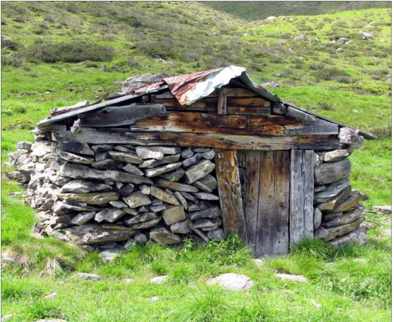
Abb. 10: Schöntal 2.029, VB Innsbruck-Land, KG St. Sigmund Intakte Hirtenhütte. Der Steinunterbau ist 1,40 m hoch, darauf liegen Holzbalken mit 15-18 x 12 cm. Eingeritzte Jahreszahlen auf den Holzbalken von 1951, 1963, 1980 außen und 1985 und 1988 innen. Innenmaße 4 x 2,5 m, Mauerstärke 0,4-0,6 m, Giebelhöhe innen 2 m
