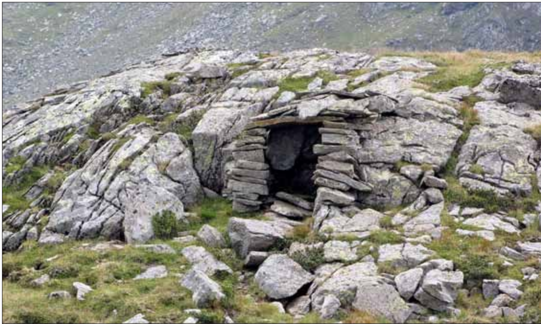
Abb. 11: Gutenbrunn 2.420 m, VB Lienz, KG. Alkus Intakter Hirtenunterstand am Felsen aus sorgfältig geschichteten seitlichen Steinplattenmauern und Steinplattenabdeckung. Innenmaße ca. 1 x 0,7 m, 1 m hoch, Mauerlänge nordseitig 0,9 m, Mauerlänge südseitig 1,5 m, Mauerstärke 0,4- 0,5 m
