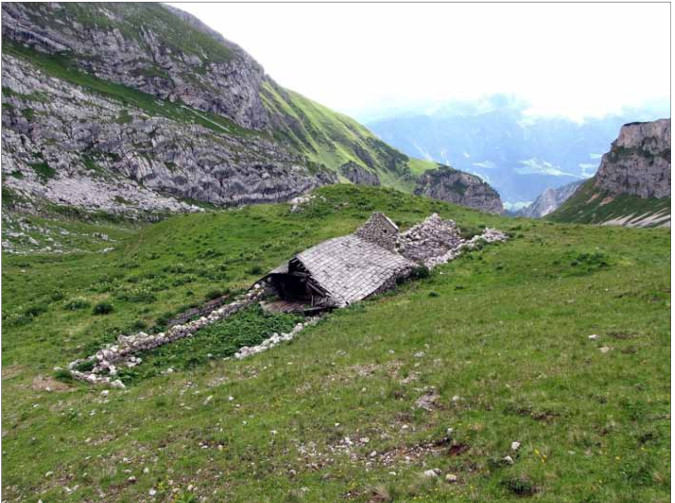
Abb. 4: Lämperalm 2.047m , VB Kufstein, KG Münster Verfallener Hochleger der 280 Hm tiefer gelegenen Schermsteinalm Gesamtlänge 40 m, Innenmaße der Ställe je 18,0 x 5,0 m, Innenmaße Hütte 5,0 x 2,5 m
