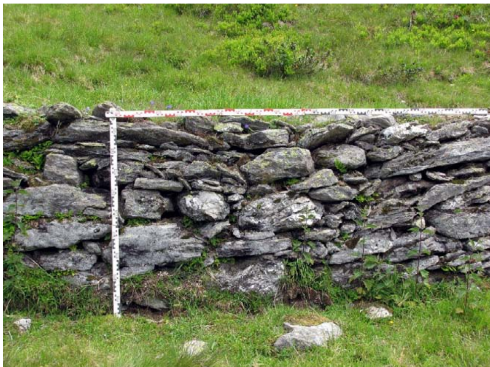
Abb. 5: Sorgfältig geschichtete Hangmauer von Objekt 2 auf der Wüstung „Wurzach“ Foto: B. Weishäupl 2013
